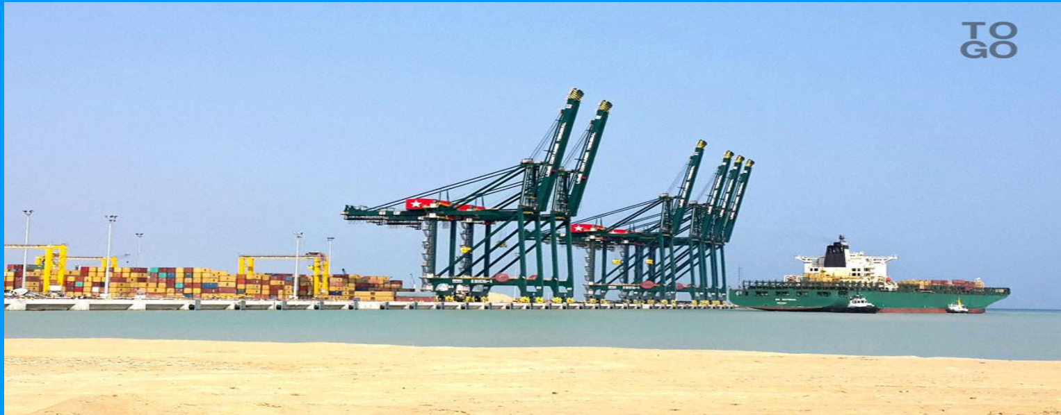
Portiques de quai
